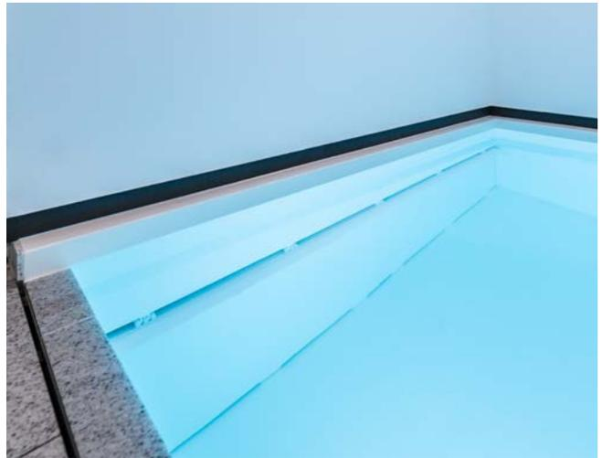
Oben: **Eine Rollladenabdeckung reduziert die Verdunstung und die Betriebskosten.** Mitte links: Kleiner Aufenthaltsbereich. Mitte rechts: **Rollladenkasten im Becken.** Unten: **Dusche.**
