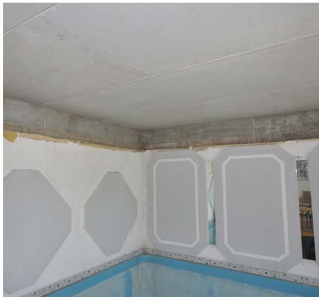
**Zu den bauphysikalischen Maßnahmen bei der Sanierung einer Schwimmhalle gehören Wärmedämmung und Dampfsperre dazu.**
