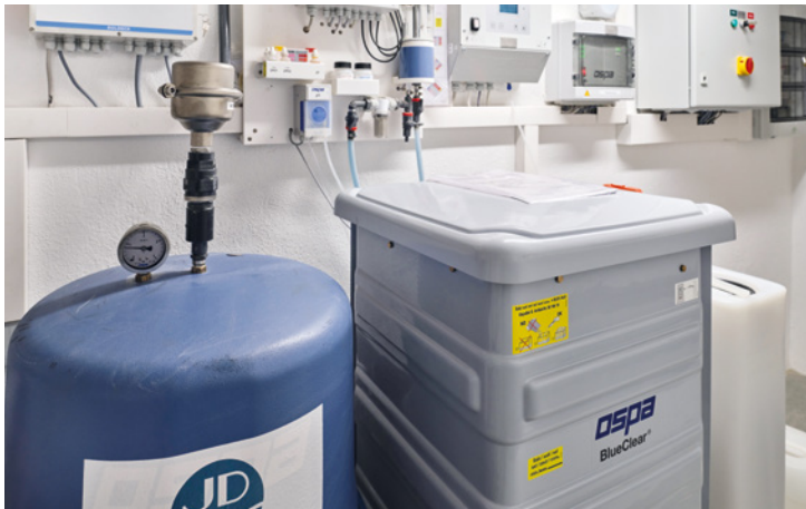
Rechts im Bild: die Salzelektrolyseanlage und darüber die Komponenten der Mess- und Regeltechnik. Außerdem gibt es einen Ozonator aus dem Hause „J.D.“, der Sauerstoff an das Poolwasser abgibt.
