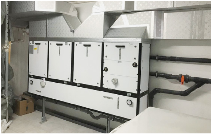
Preisgekrönte Lüftungstechnik von Poolair: Der modulare Aufbau sorgt auch bei Sanierungen für Flexibilität. Herzstück der Anlage ist ein Plattenwärmetauscher mit sparsamer Regelung und Steuerung.
