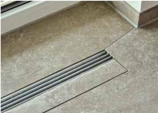
Über diese Schlitzschienen wird die entfeuchtete und erwärmte Luft in die Schwimmhalle zurückgeführt, wo sie dann für ein angenehmes Raumklima sorgt.
