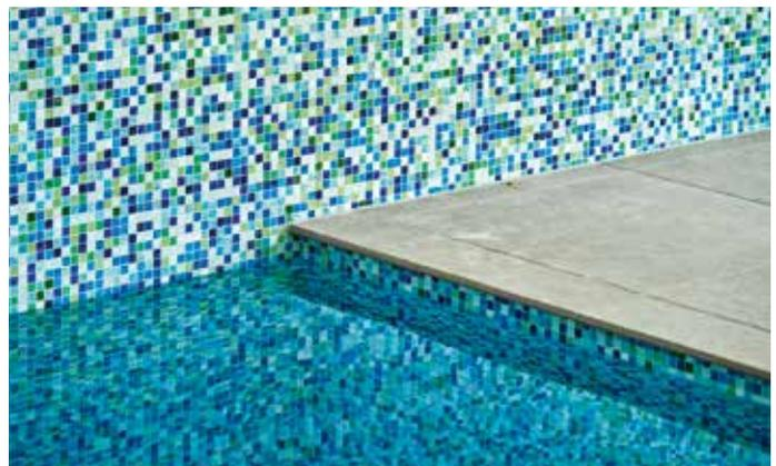
Bild oben rechts: Hier zeigt sich die saubere Verarbeitung der Beckenauskleidung inklusive der Verbindung zur Beckenumrandung aus Naturstein von Meyer Bauabdichtung.
