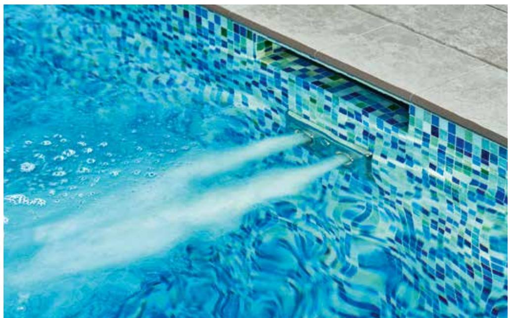
Rechts: Mit der zweidüsigen Gegenströmung halten sich die Poolbesitzer fit. Darüber ist der Skimmer platziert, der das Oberflächenwasser absaugt.
