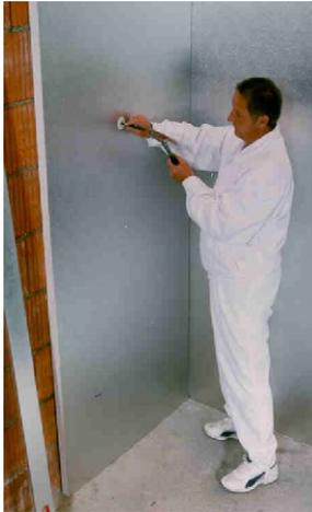
Die ISO-Feuchtraumdübel sind mit einer selbstklebenden Alu-Dichtscheibe ausgerüstet und müssen daher nicht mehr extra mit Alu-Streifen überklebt werden. Die Schutzfolie auf der Rückseite der Dübel ist vor der Verwendung zu entfernen.
