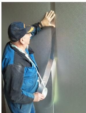
Zur Vereinfachung beim Verlegen kann die Fugenbandrolle mittels **Trägerband** um den Hals gehängt werden.
