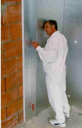
Die großformatigen ISO-PLUS-ELEMENTE Typ III (1000x2500 mm) werden sowohl an der Decke als auch an den Wänden eingesetzt und dienen insbesondere als Trägerelement für die ISO-Schwimmhallenputze.
