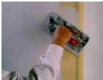
Zur Gestaltung der Oberfläche kann dann ein Schwimmhallenputz aus dem ISO-Sortiment aufgezogen oder mit dem ISO-Malgrund eine glatte Fläche geschaffen werden. Darauf sind dann alle malertechnischen Endgestaltungen möglich.
