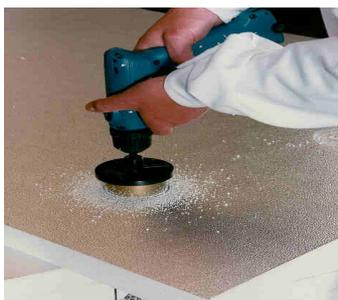
Aussparungen - z.B. für Elektroleitungen - werden auf der Rückseite des ISO-PLUS-ELEMENTES aus dem Polystyrolschaum herausgeschnitten oder gefräst.
