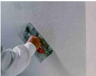
Nach Trocknung wird der **ISO-Feuchtraumspachtel** flächig aufgezogen und zur Armierung das ISO-Glasgittergewebe überlappend eingebettet. Je nach erforderlicher Ebenheit ist die Fläche nach Durchtrocknung nochmals mit einer dünnen Spachtelschicht planeben abzuziehen. Die **Gesamt-Schichtdicke** muss **mindestens 2 mm** betragen.
