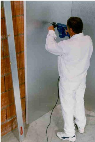
Die ISO-PLUS-ELEMENTE Typ III werden mit ISO-Hartschaumkleber verklebt. Auf der Baustelle muss in den Kleber etwa 20 % Portland-Zement (5 kg pro Eimer) knotenfrei eingerührt werden.
